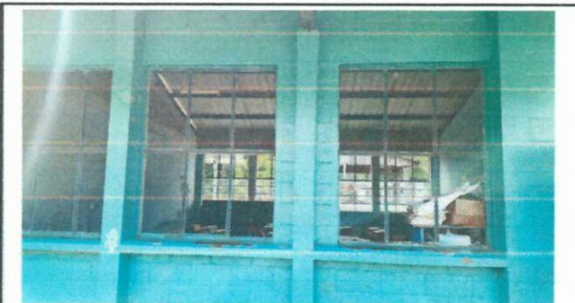
Foto 5: MEJORAMIENTO DE BALCONES
