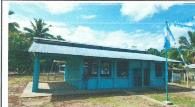
Foto1: SUSTITUCION DE CUBIERTA DE LAMINA
