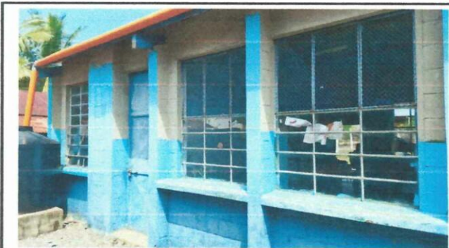
Foto 3: PINTURA EN PAREDES EXTERIORES E INTERIOR
